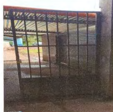
Foto 2: Porton Principal. Se observa que es necesario la modificación y mantenimiento de porton debido a que no se puede abrir en su totalidad de un lado debido a su altura con el techo.
