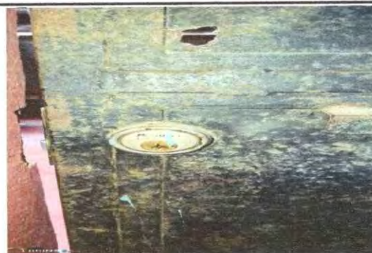
Foto 4: Chapa aula 1, Debido a la antigüedad de las puertas, es necesario el cambio de la chapa, ya que no se cuenta con llave.
