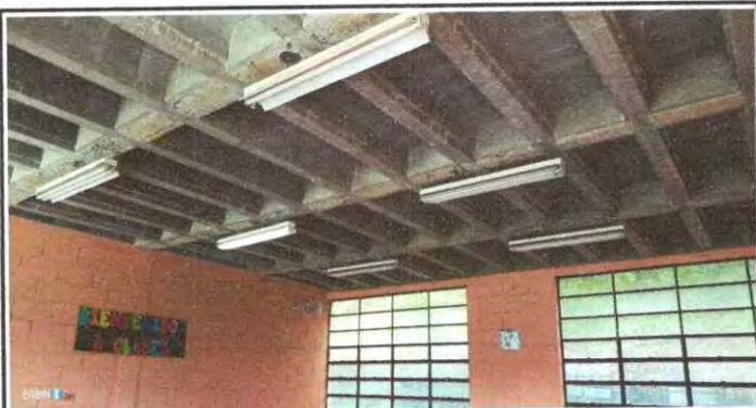
Foto 3: Iluminación del modulo 3, no funcionan al igual que los tomacorrientes, por lo cual se debe cambiar las líneas principales.
