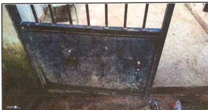
Foto 3: Porton principal, Se observa que es necesario de nuevo repintar el porton por el mal estado en que se encuentra.
