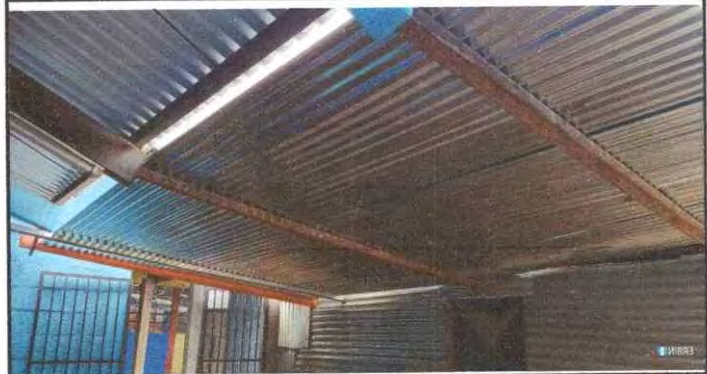
Foto 4: Estructura techo modulo 1. Se observa que el techo no esta totalmente asegurado ya las costaderas solo estan sujetas con alambre y las laminas sin atornillar.
